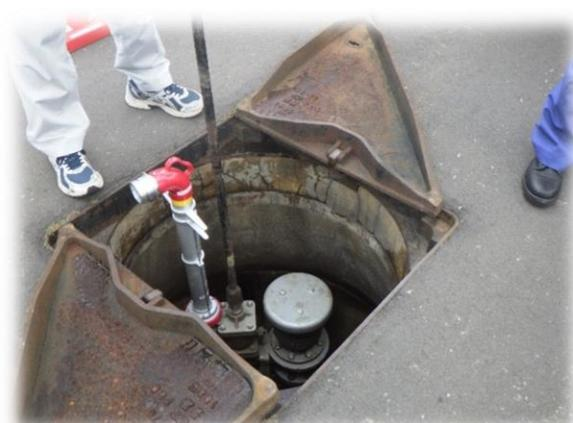
給水コンテナへ給水栓付き空気弁から給水
