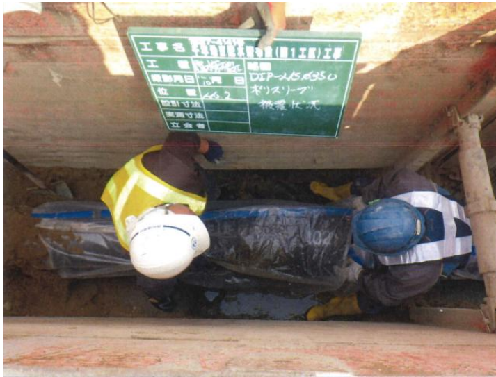
図表 4-13 配水管布設工事の様子
