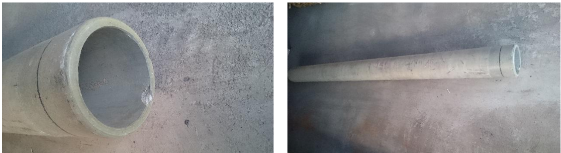
図表 3-13 石綿セメント管（耐震性の低い水道管）
