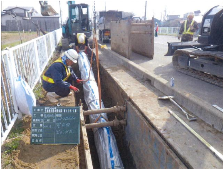
図表 3-22 配水管布設工事の様子
