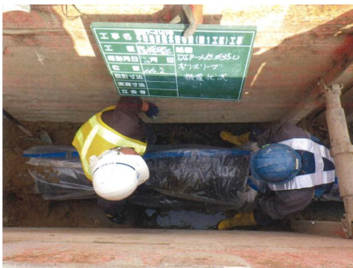
図表 4-1 3 配水管布設工事の様子
