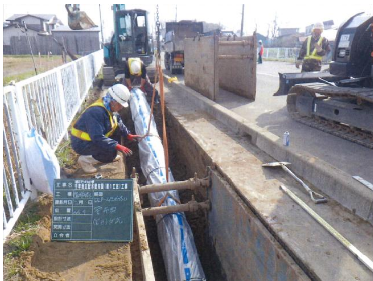
図表 3-22 配水管布設工事の様子
