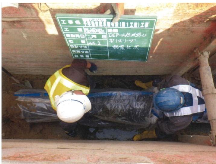
図表 4-1 3 配水管布設工事の様子
