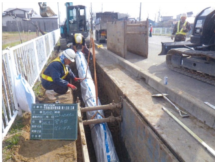
図表 3-22 配水管布設工事の様子
